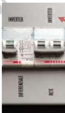
NB: le **operazioni trasmissione satellitare** vanno sempre effettuate attraverso **l'alimentazione elettrica da inverter**. La rete 220 V, se disponibile, va impiegata per la carica in tampone della batteria di servizio.
